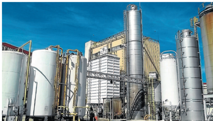
Instalaciones de la planta de Ercros en Monzón.
